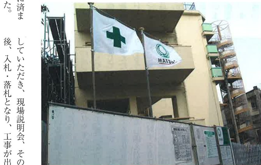
本館の解体に向け囲いや足場が組まれました。
