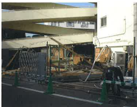
自転車作業室(プレハブ)の解体。
