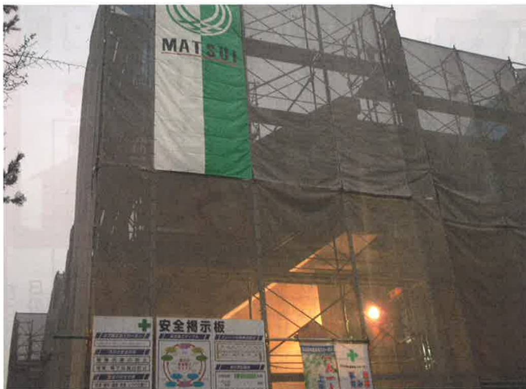
内装工事も始まりました。11月20日現在
