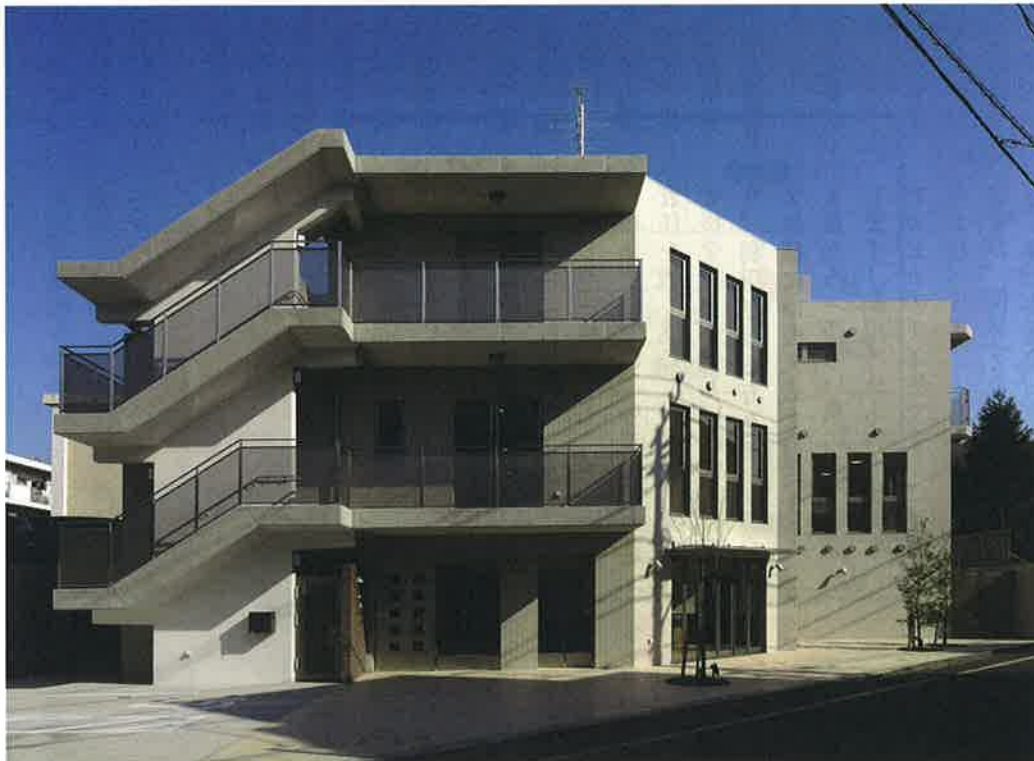
建物も完成し、いよいよ「新・泉の家」がスタートします。
