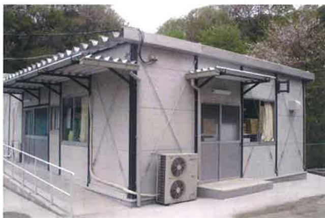
仮設のプレハブ作業場
