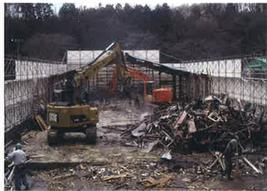
作業棟が解体され、この場所に新しい建物が建ちます
