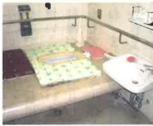
改修予定の和式トイレ
