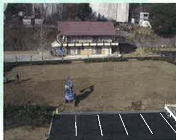
屋上から庭を眺めた風景（一部工事中）
